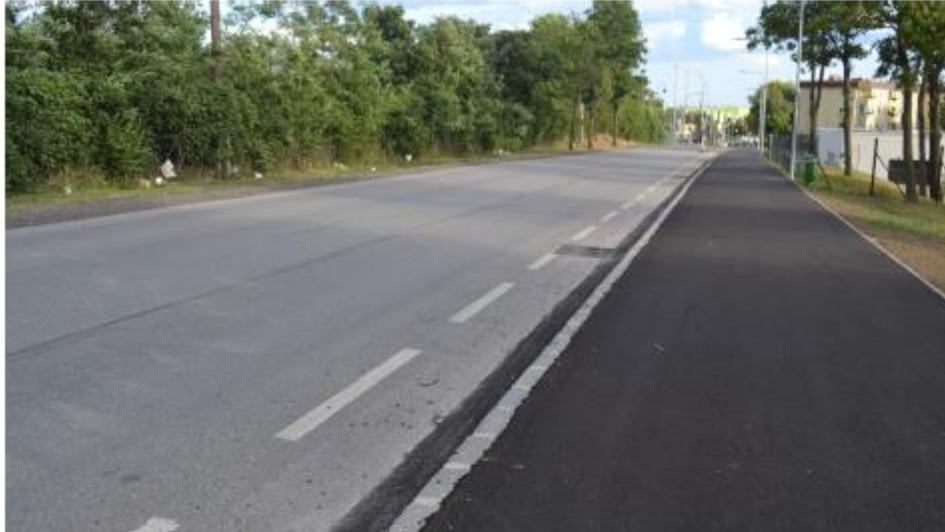
Abbildung 4: Fertiggestellter Radweg entlang der Achauerstraße zwischen Wien und Achau (Niederösterreich). Eine ähnliche Umsetzung ist entlang der B1 sowie der B44 möglich. Foto: Nicole Frisch
